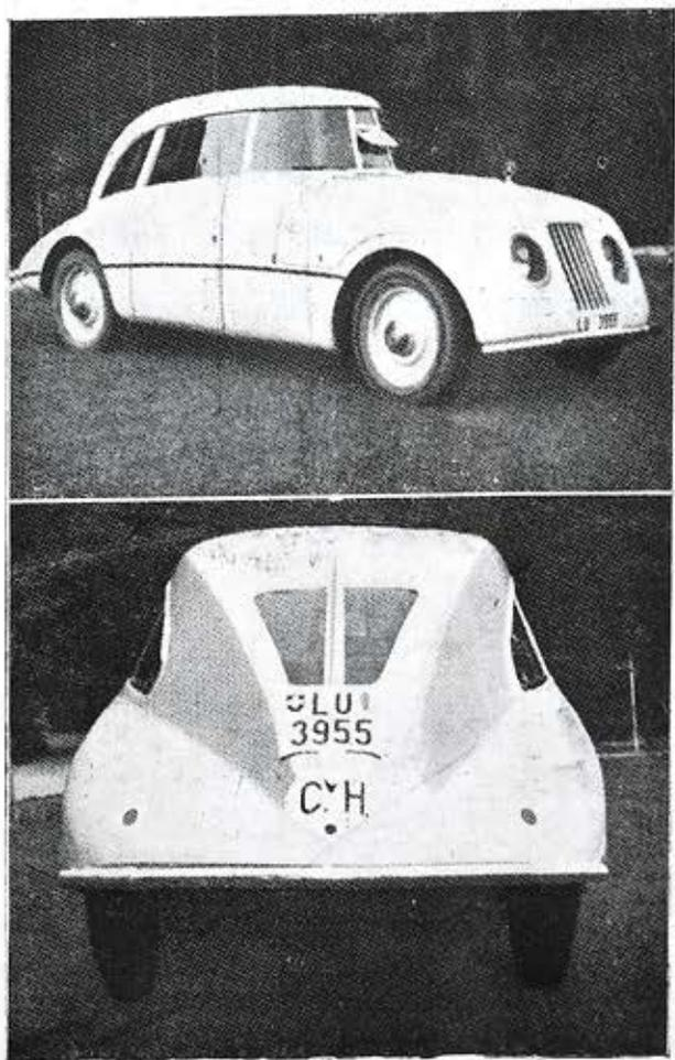
Dos vistas de la carrocería aerodinámica Jaray, sobre chasis Mercedes.
